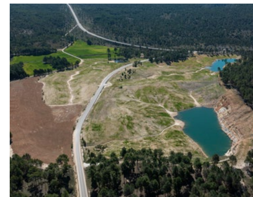
Figura III. Vista aérea de la restauración ejecutada. Mayo 2022.
